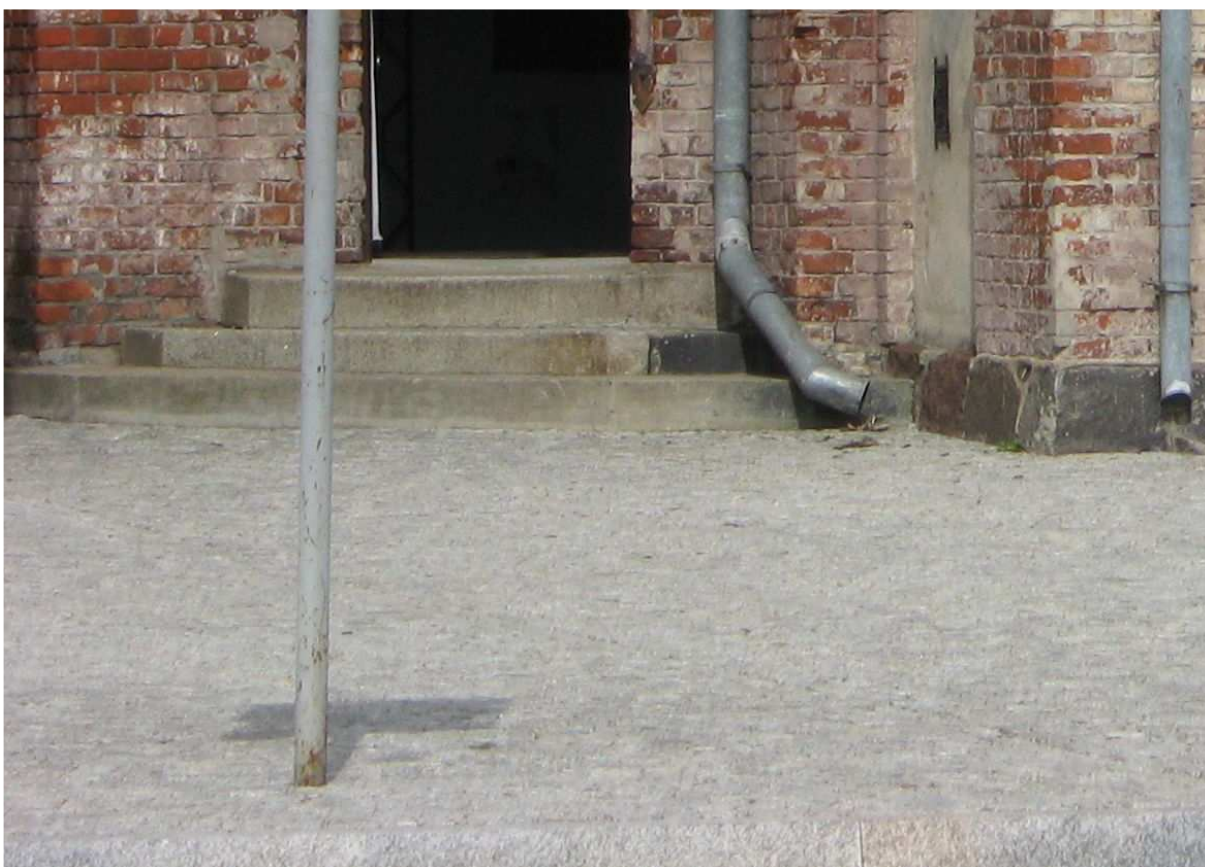
ZDJĘCIE NR 12 SCHODY ZEWNĘTRZNE BETONOWE (widoczne zabrudzone i częściowo wyeksplotowane stopnie schodowe oraz zły stan faktury elewacji)
