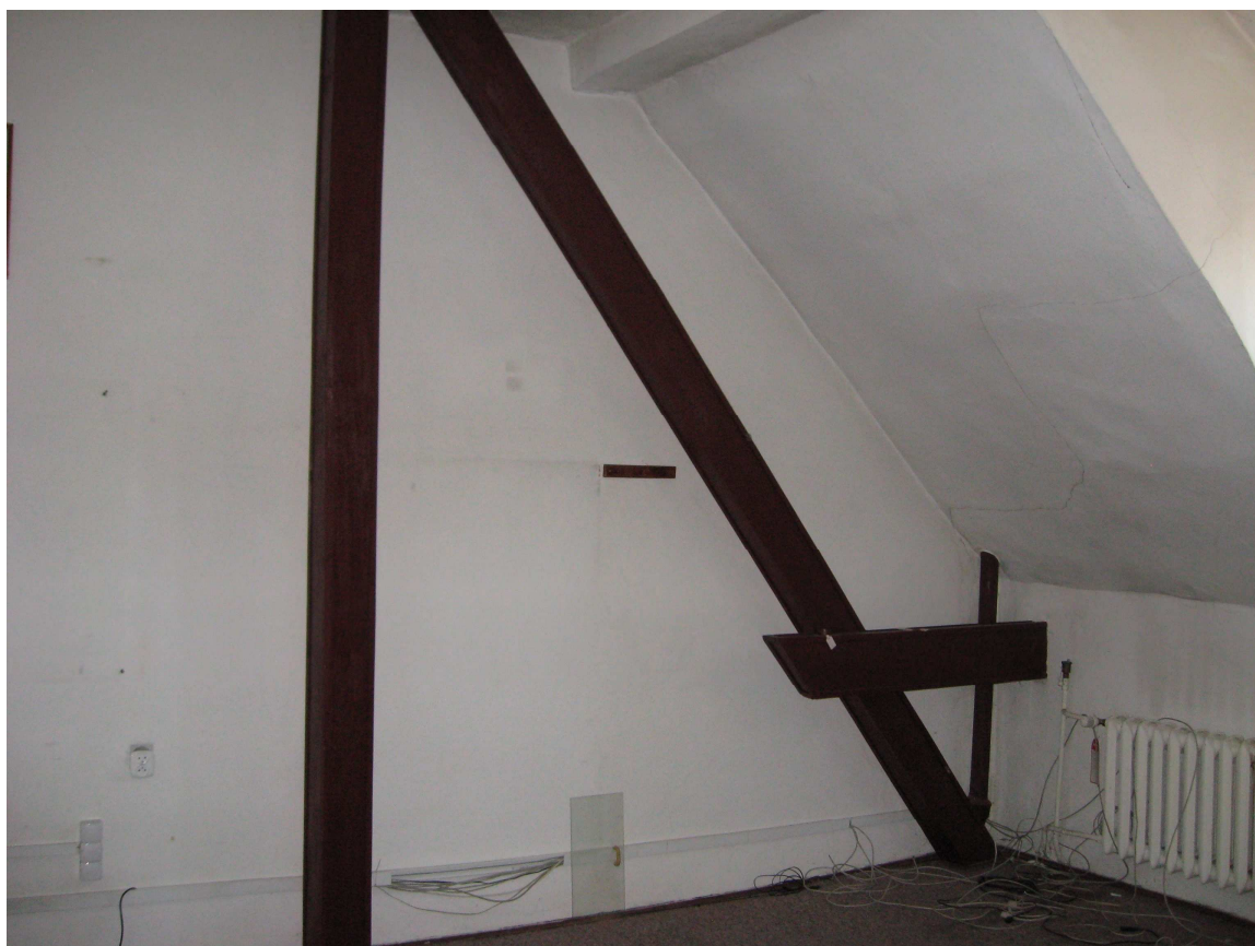
ZDJĘCIE NR 10 FRAGMENT KONSTRUKCJI WIEŻBY DACHOWEJ ORAZ PODBITKI (widoczny dobry stan mieczy słupów, zastrzałów, kleszczy zabezpieczonych farbą olejną oraz zarysowania na powierzchni podbitki)
