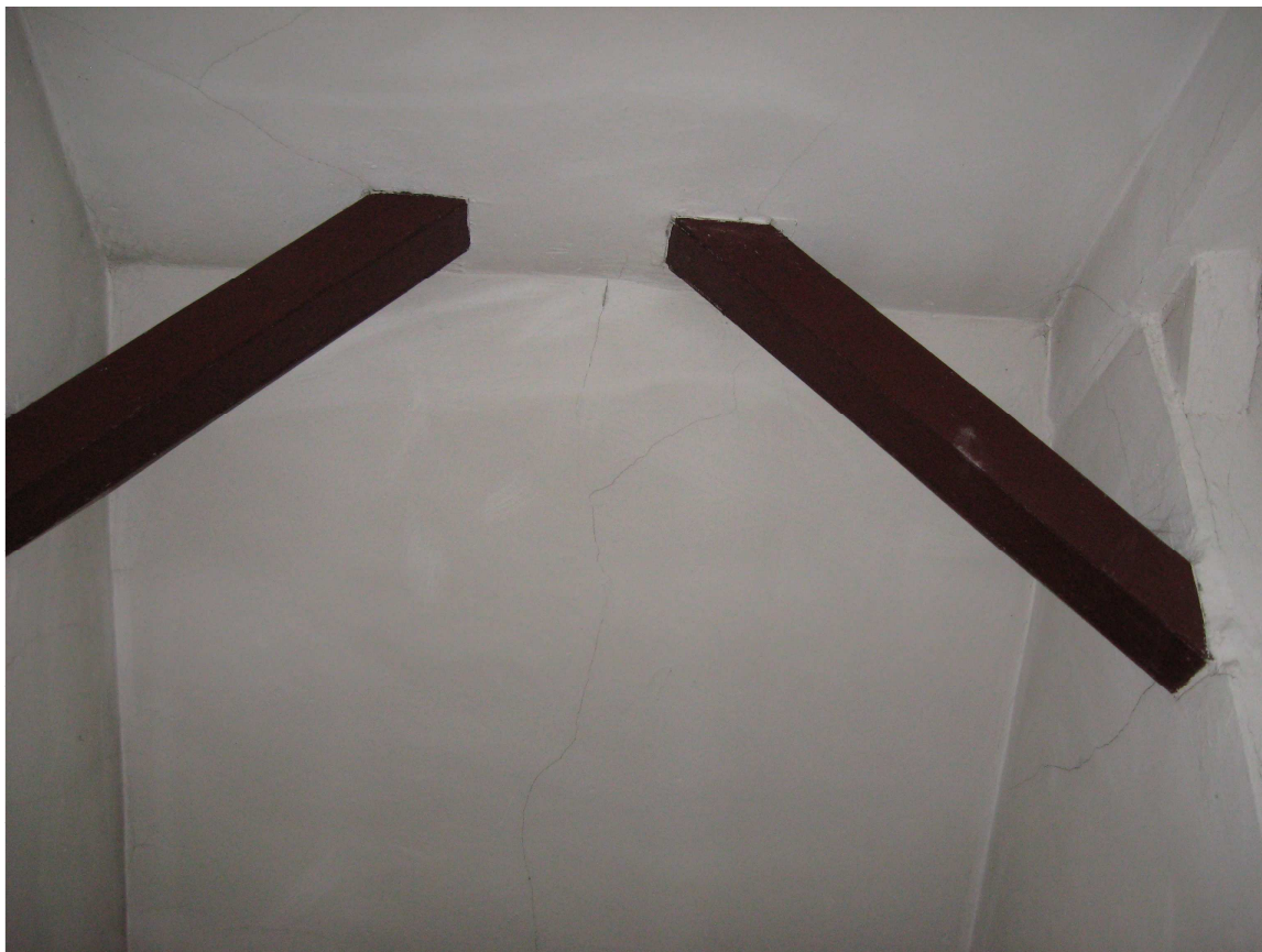
ZDJĘCIE NR 10 FRAGMENT KONSTRUKCJI WIEŻBY DACHOWEJ ORAZ PODBITKI (widoczny dobry stan mieczy słupów, zastrzałów, kleszczy zabezpieczonych farbą olejną oraz zarysowania na powierzchni podbitki)
