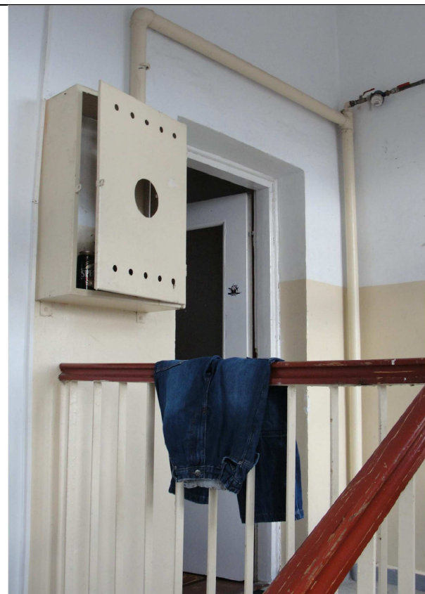
Fot.14. Widok bocznej klatki schodowej w obrębie mieszkań nieobjętych opracowaniem.
