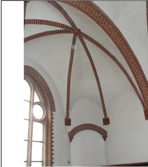
Fot.3. Sklepienie w głównej klatce schodowej.
