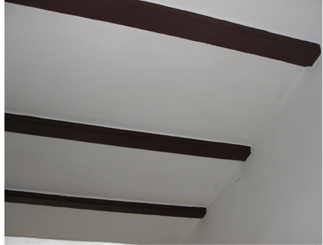
Fot.4. Zabytkowy drewniany strop w sali konferencyjnej.
