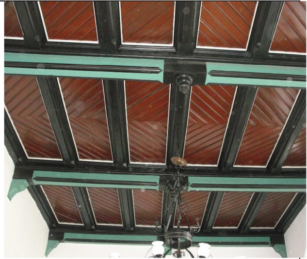
Fot.4. Zabytkowy drewniany strop w sali konferencyjnej.
