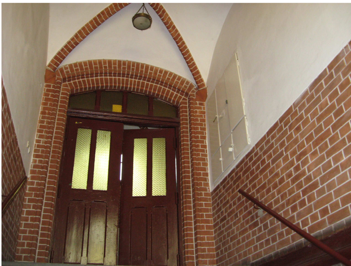
ZDJĘCIE NR 6 NADPROŻOWE SKLEPIENIE CEGLANE NAD DRZWIAMI (widoczne ceglane elementy nadproża oraz zadowolający ich stan techniczny)
