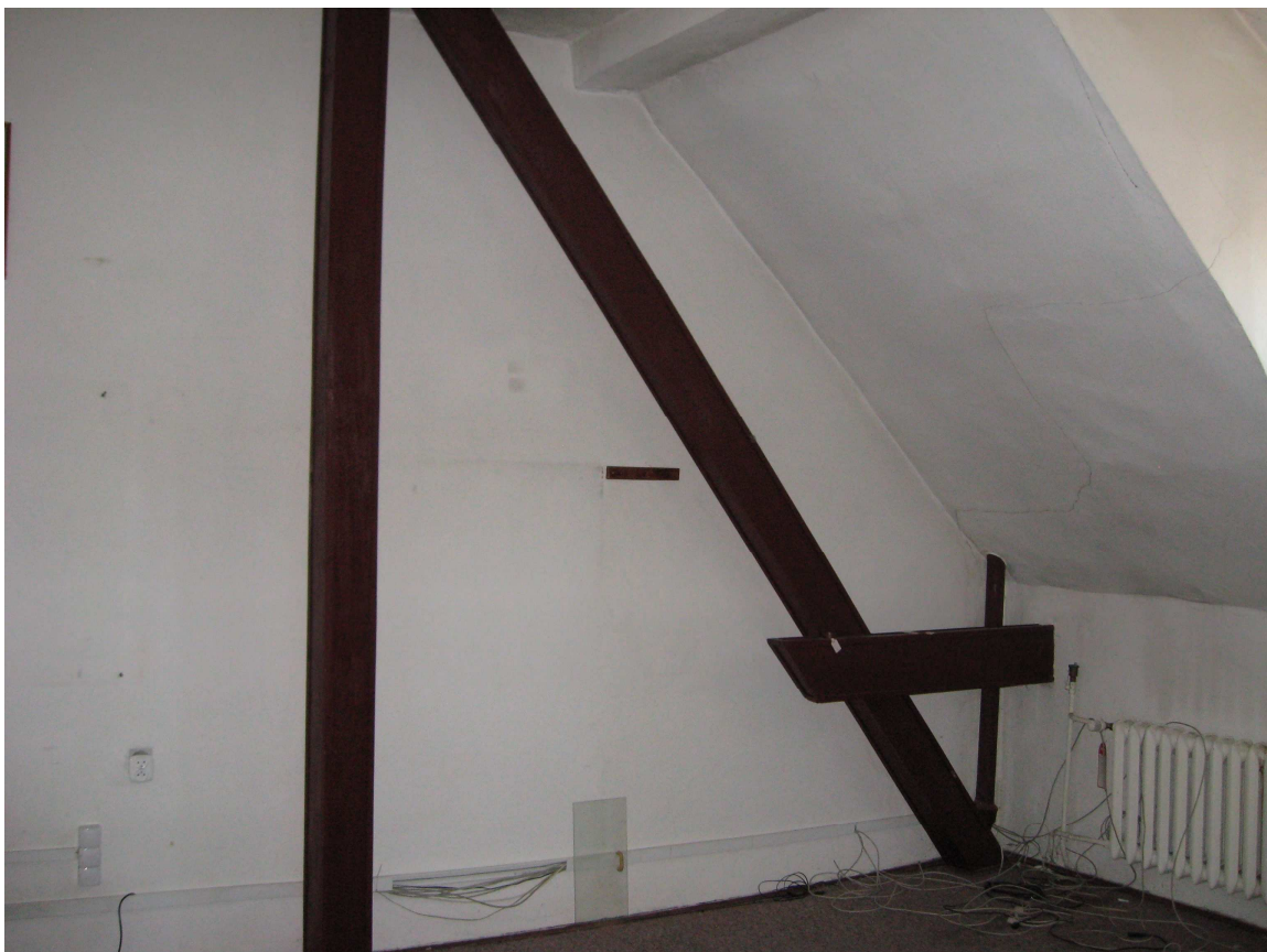
ZDJĘCIE NR 10 FRAGMENT KONSTRUKCJI WIĘŻBY DACHOWEJ ORAZ PODBITKI (widoczny dobry stan mieczy słupów, zastrzałów, kleszczy zabezpieczonych farbą olejną oraz zarysowania na powierzchni podbitki)
