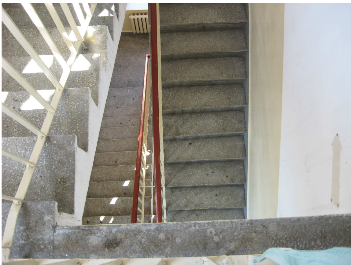
ZDJĘCIE NR 8 SCHODY WEWNĘTRZNE W CZĘŚCI SKRAJNEJ (widoczne żelbetowe schody wykończone lastriko znacznie wyeksplotowanym i wytartym)
